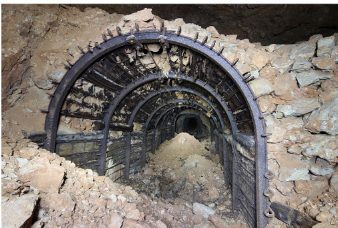
Boisage mixte, mine de zinc - plomb - cadmium - cuivre (Gard)
